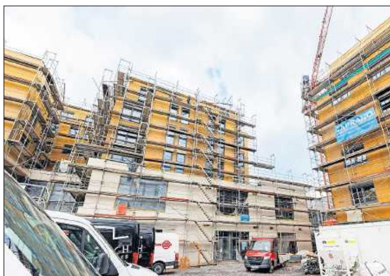
Im Innenhof sind Parkplätze und Grün vorgesehen. FOTO: VIEW
