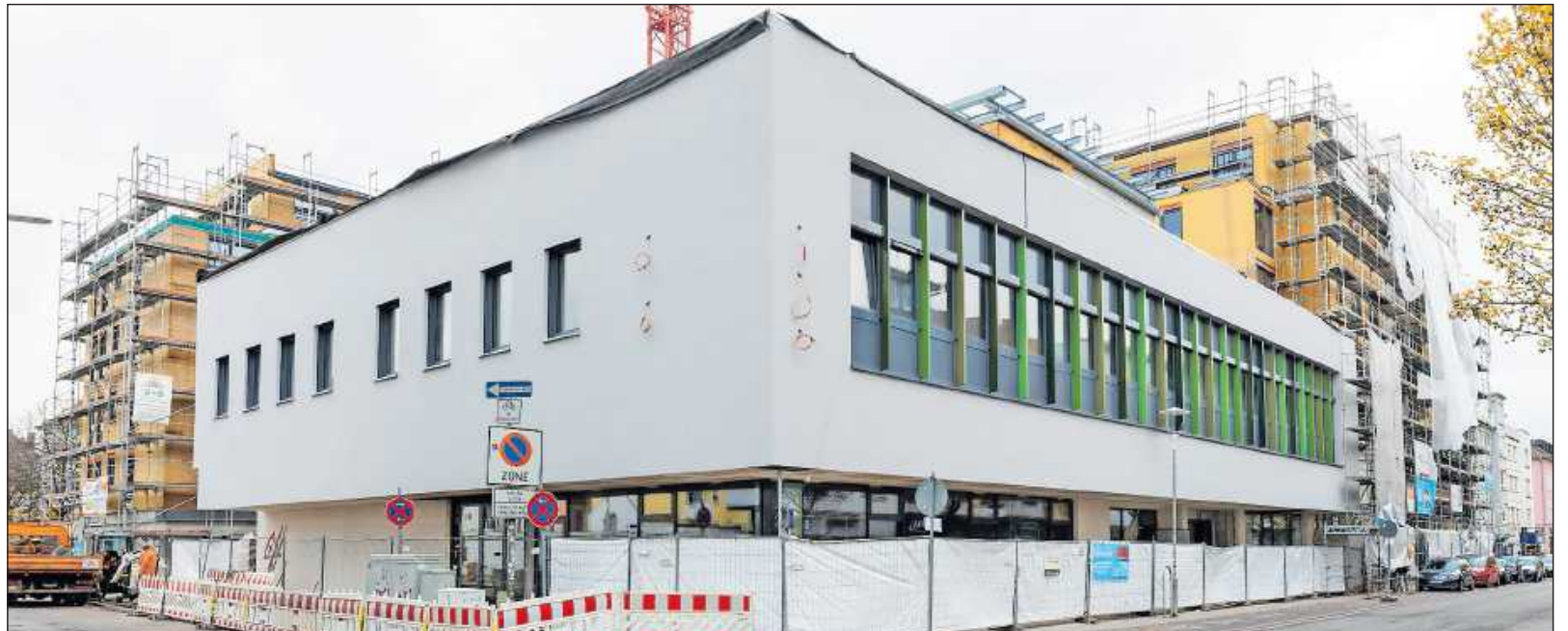
Das ehemalige C&A-Gebäude wurde umgebaut. FOTO: VIEW
